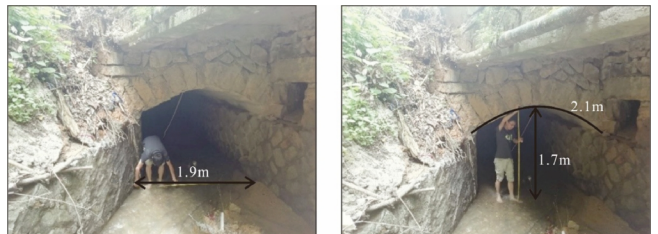
图4 紫莲桥后山冲沟下游居民区沟排水涵洞
